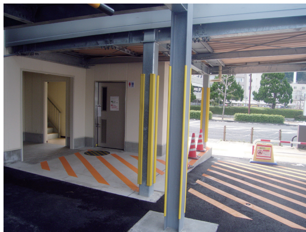
多目的トイレ・乗車スペース
